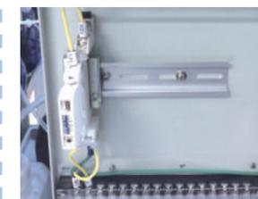
装置を設置する施設の要件で落雷時の濃度出力信号ラインへの保護が必要な場合、信号用アレスタを追加できます。
